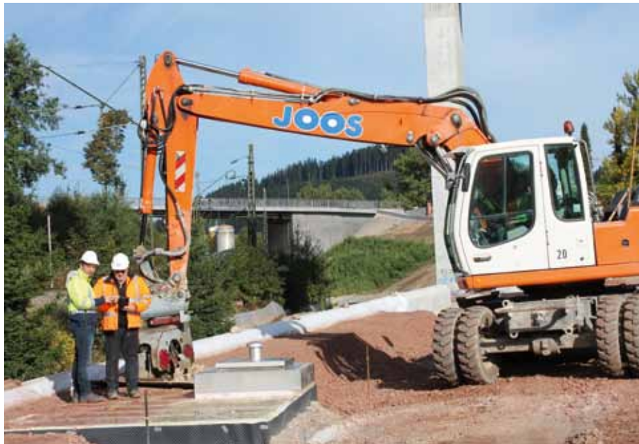
Vermaßen und Beschriften der Baustellenfotos zur Dokumentation der Aufmaße
