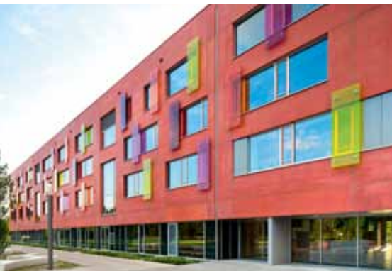
Rot durchgefärbter Sichtbeton ist Markenzeichen des Willibald-Gluck-Gymnasiums, Neumarkt i.d.OPf.
