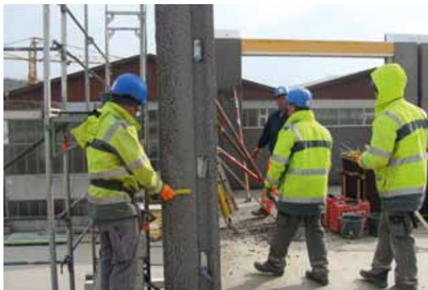
Versetzen von Blähtonfertigteilen beim Büroneubau von Fensterle
