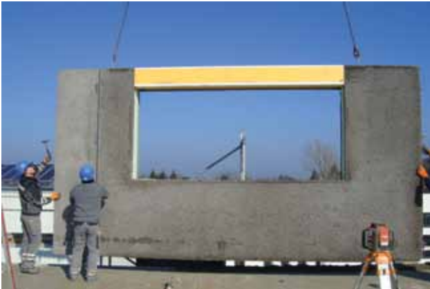
Versetzen eines Blähtonfertigteils beim Büroneubau von Fensterle
