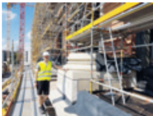
Berliner Schloß Baustelle 3 Südportal Säulenbasen
