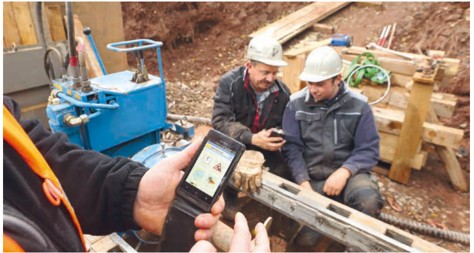
Fotodokumentation kurz vor Feierabend: So kann AVE dem Bauherrn jederzeit die ausgeführte Leistung belegen, und Unstimmigkeiten sind schnell geklärt. | Fotos: 123erfasst
