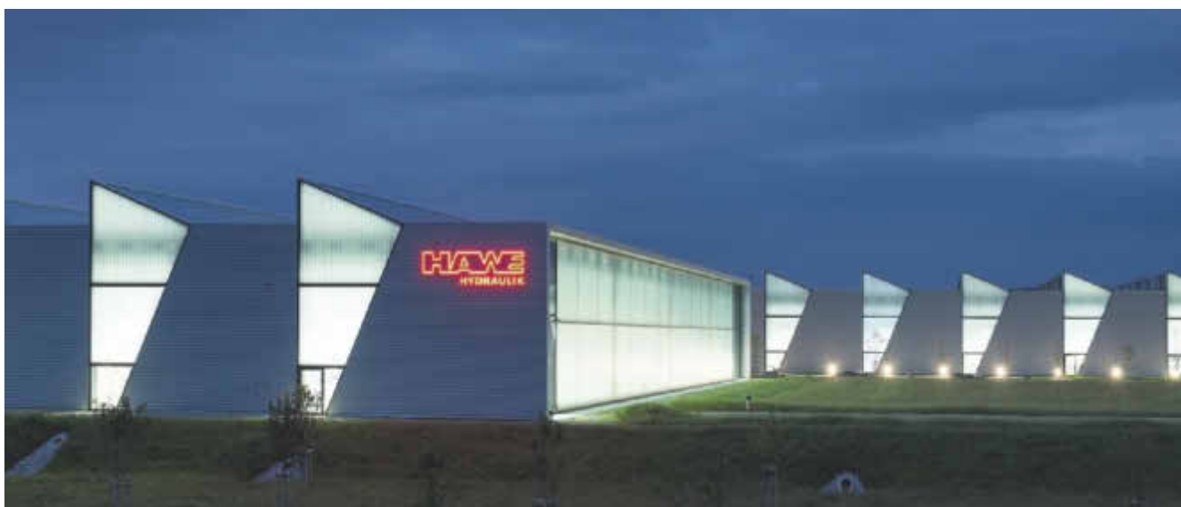
Nachts entsteht ein stimmungsvolles Bild dank der transluzenten Wärmedämmung in der Profilglas-Fassade.
