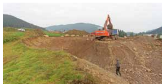
Bau eines Versickerungsbeckens im Gewerbegebiet Titisee-Neustadt
