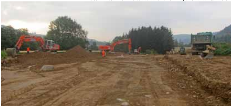
Straßenbauarbeiten im Gewerbegebiet in Titisee-Neustadt
