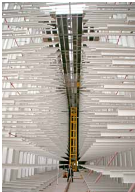
Bau eines Hochregallager für Häcker Küchen in Rödinghausen
