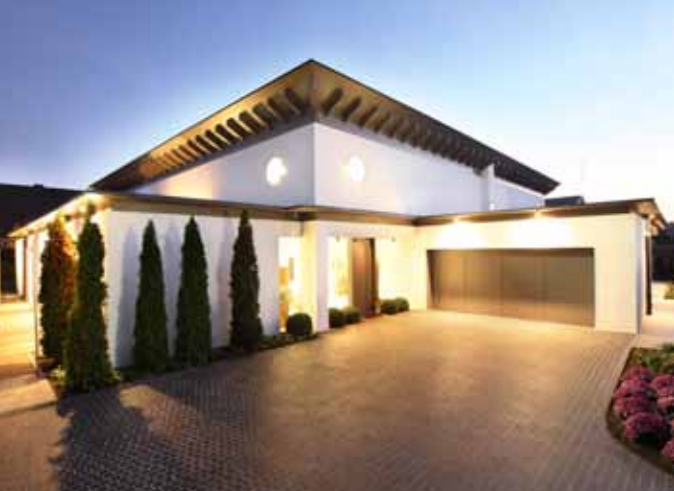
Neubau eines KfW-Effizienzhaus 70 mit Einliegerwohnung in Löhne
